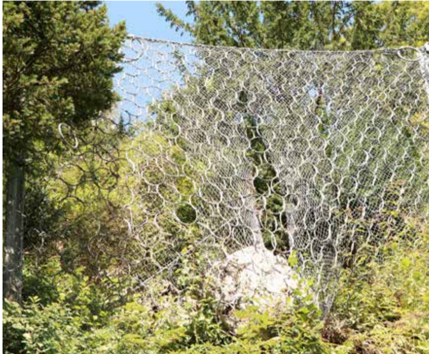
Stein des Anstosses: Die Auffangnetze in Weesen halten dem knapp drei Tonnen schweren Brocken locker stand.
